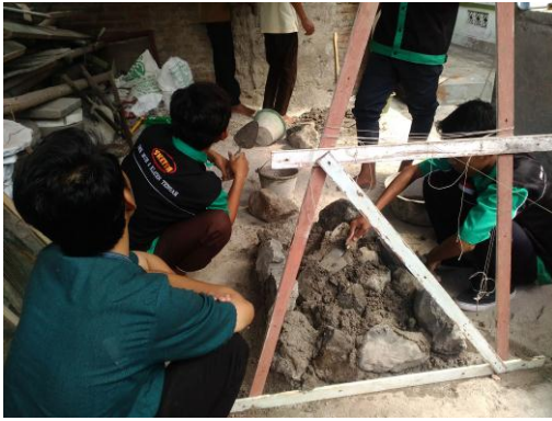
Gambar 1. Mengajar praktek pemasangan pondasi batu pecah
