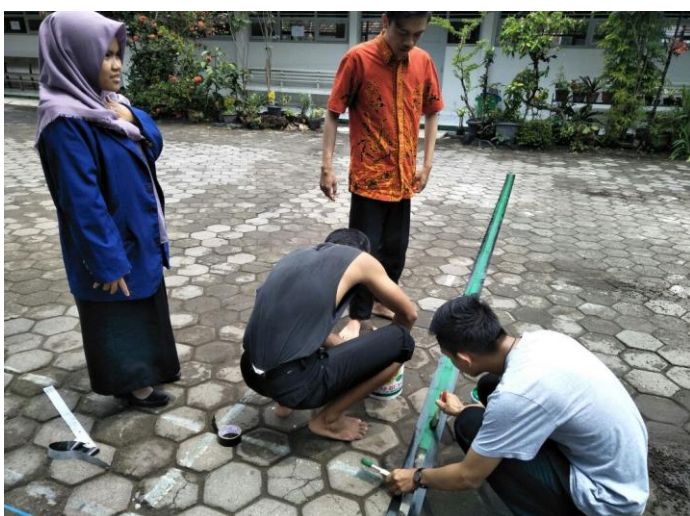
Gambar 9. Pengecatan Garis Lapangan
