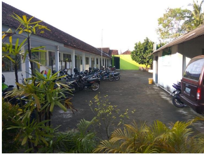
Gambar 1. Kondisi Gedung SMK Ma'arif 1 Piyungan
