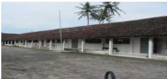
Gambar 1. Bangunan SMK Ma'arif 1 Piyungan
