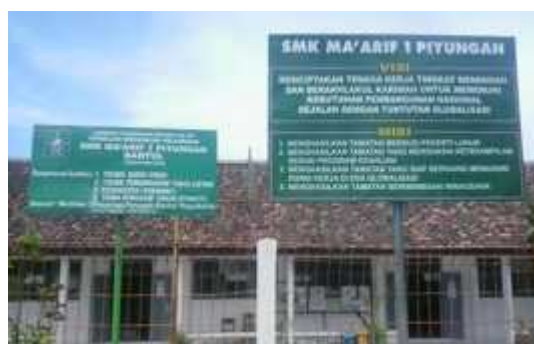
Gambar 2. Gedung SMK Ma'arif 1 Piyungan Tampak Depan
