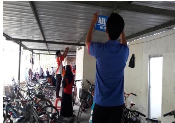
Pemasangan Plang Parkir
