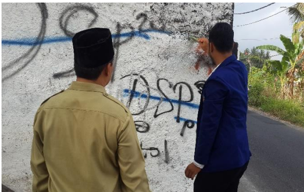
Mengecat Ulang Tembok Sekolah
