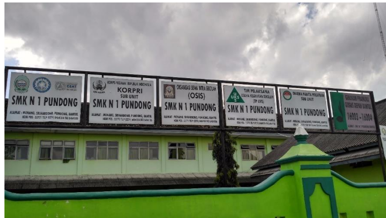
Gambar 1 Gedung SMK N 1 Pundong Tampak Depan
