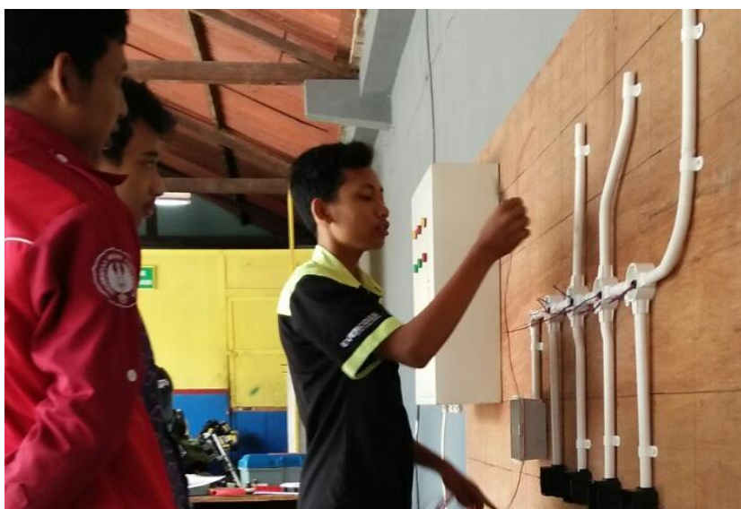
Kegiatan Pendampingan Persiapan LKS Instalasi Listrik
