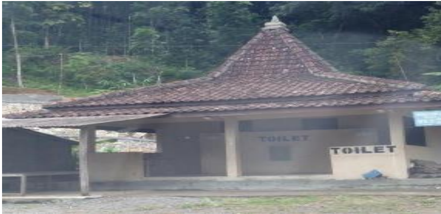
Foto 4. Fasilitas yang ada di sekitar objek wisata Waduk Sermo
