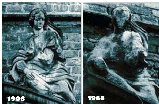
Gambar 9. Perbandingan Foto Patung Sebelum (1908) dan Sesudah (1968) Terpapar Hujan Asam Sumber gambar: EPA (2008: 13).
