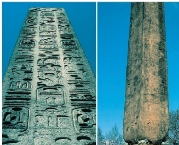
Gambar 8. Obelisk Sebelum dan Sesudah Terpapar Hujan Asam Sumber gambar: Hewitt, Lyons, Suchocki, Yeh. (2007: 274).
