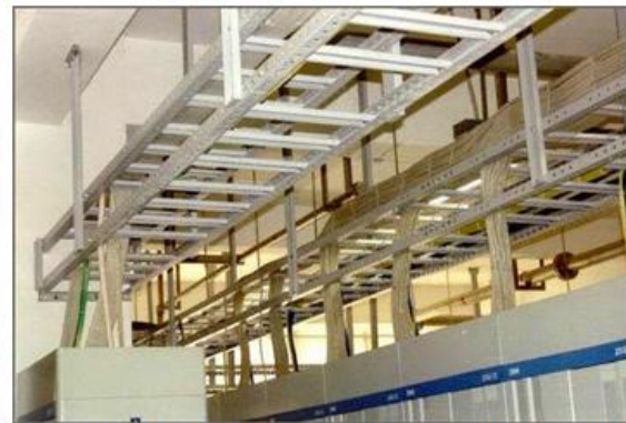
Gambar 14. Pemasangan kabel tray ladder secara horisontal
