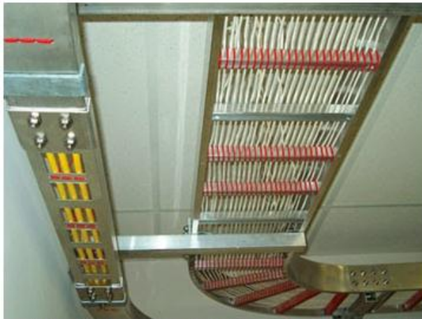
Gambar 15. Pemasangan kabel tray ladder secara vertikal
