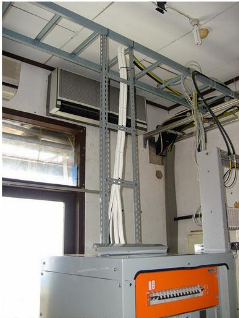
Gambar 16. Pemasangan kabel tray ladder secara horisontal dan vertikal
