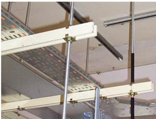
Gambar 13. Pemasangan kabel tray berlubang secara horisontal
