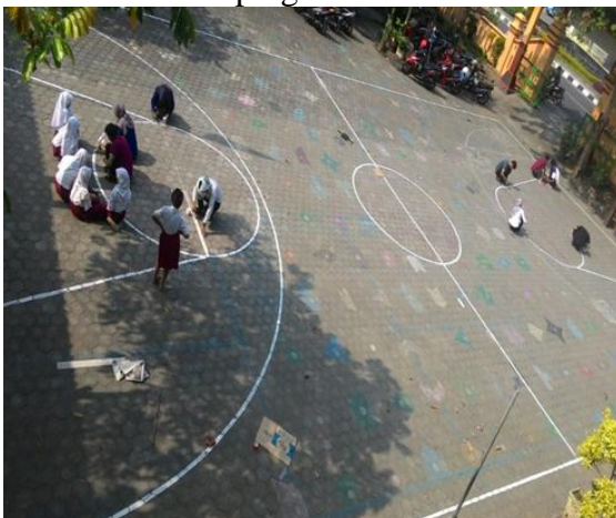
Pengecatan lapangan basket
