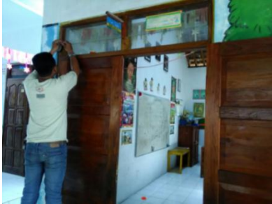
Pemasangan bel di kelas B
