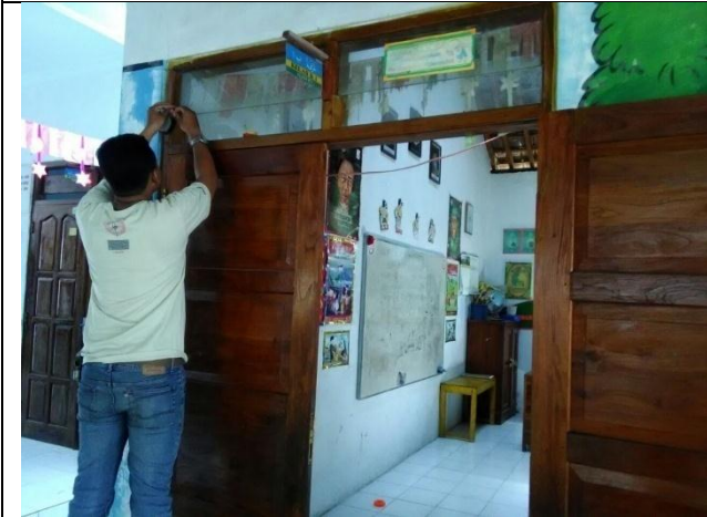
Pengadaan dan pemasangan bell
