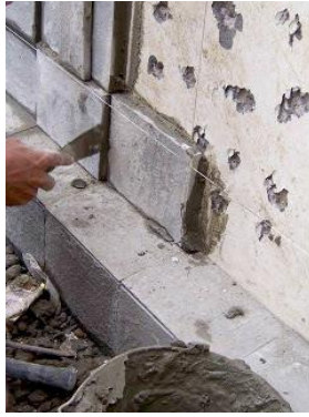
Awal pemasangan batu alam
