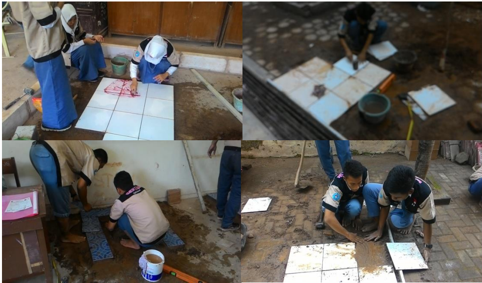
Finishing Bangunan kelas XI TKBB
