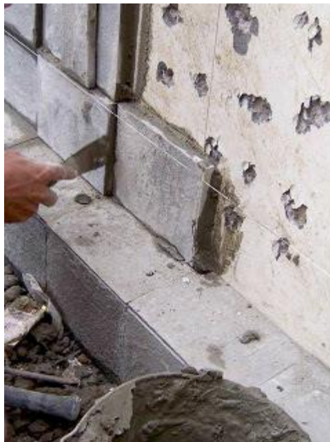
Awal pemasangan batu alam
