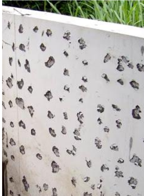
Tembok yang akan dipasang batu alam.
