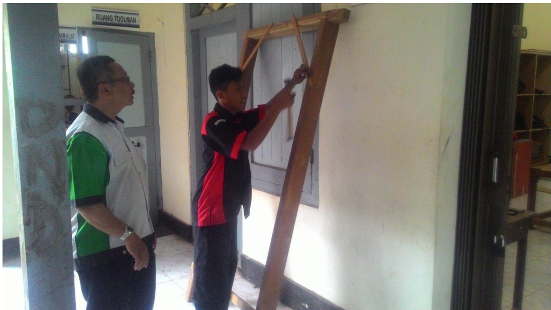
Gambar 7. Guru pembimbing mengawasi praktik membuat kusen
