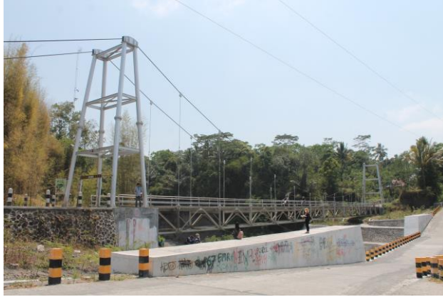
Gambar 7. Perpaduan antara jembatan rangka dan jembatan gantung
