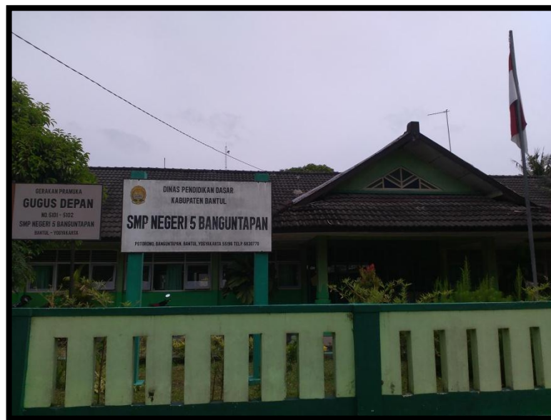
Gambar I. Depan Gedung SMP Negeri 5 Banguntapan (Sumber: Dokumentasi Shinta Nur Riftisia, 2016)
