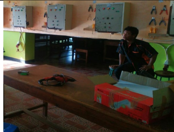
Setelah Pengerjaan Proyek
