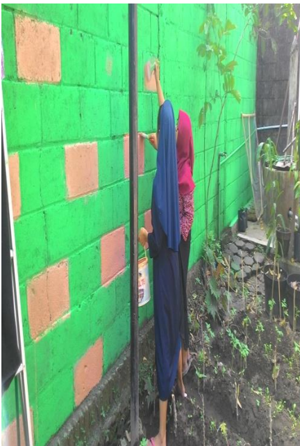
Gb. Pengecatan tembok
