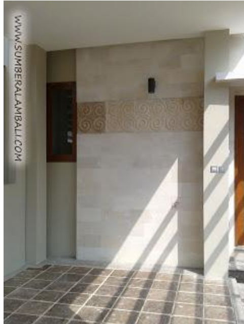
Gambar 9. aplikasi batuan pada dinding gedung
