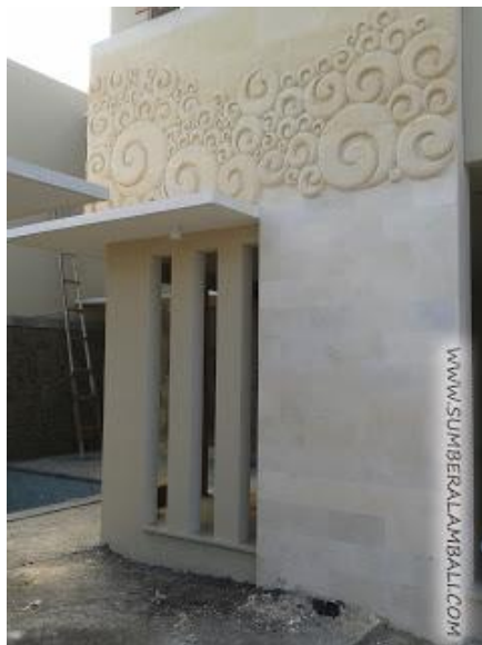
Gambar 7. aplikasi batuan pada dinding gedung
