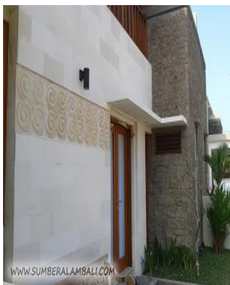
Gambar 8. aplikasi batuan pada dinding gedung
