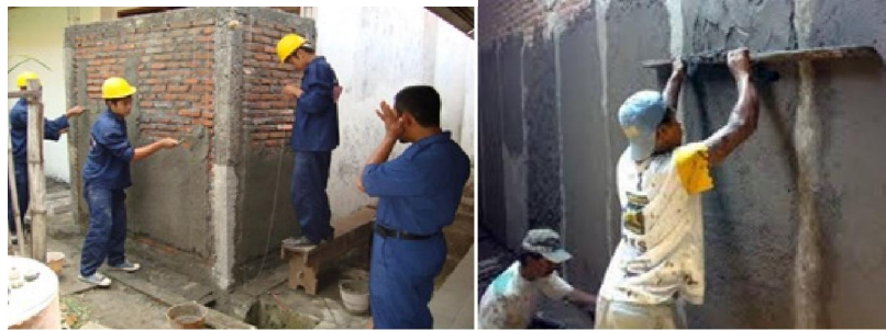
Gambar 1. Pekerjaan finishing basah
