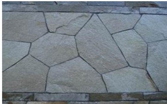
Gambar 6. Pemasangan batu alam pada tembok
