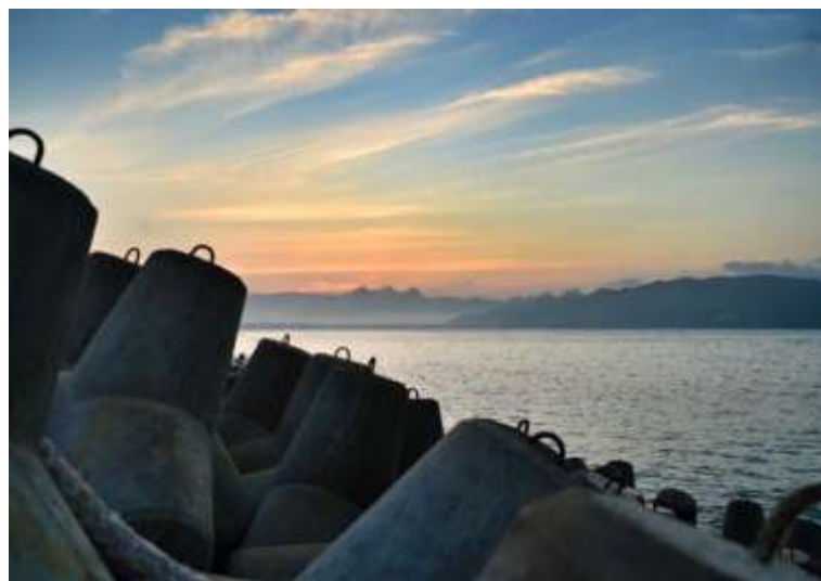
Gambar 4 : Pemecah ombak sebelah barat pantai Teleng Ria
