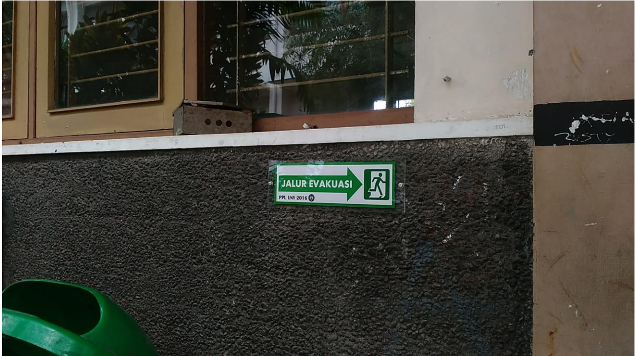
Gambar 5. Foto Jalur Evakuasi di luar bengkel (BLS dan BLU) gedung Teknik Otomasi Industri.
