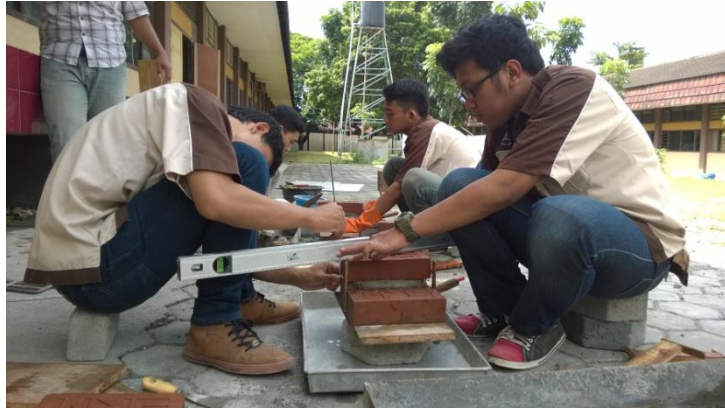
Gambar 40. Pengecekan kedataran dengan waterpass
