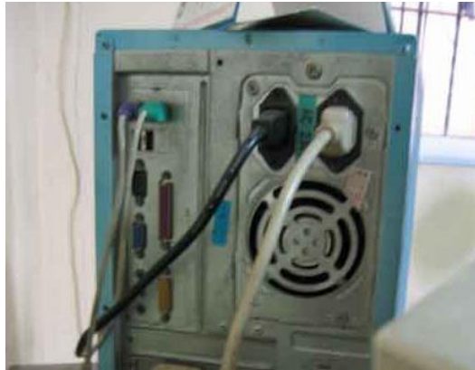
Gambar 30. Pemasangan Kabel Power
