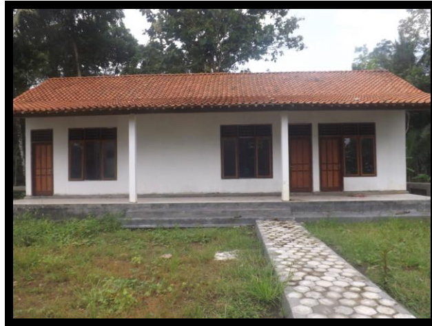
Gambar. Tampak Depan Bangunan Pos PAUD Gotong Royong
