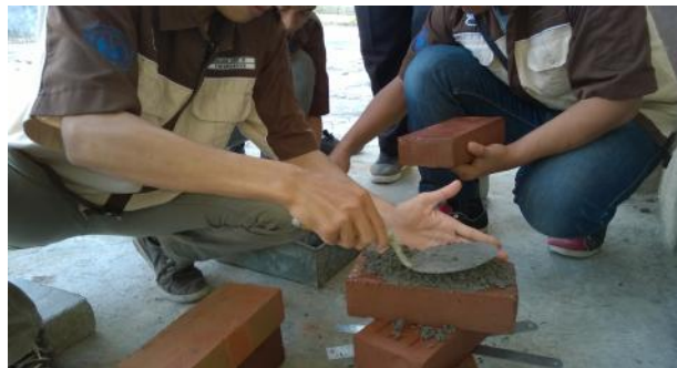
Gambar 48. Penyebaran mortar pumice dengan cetok
