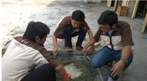
Gambar 47. Pengadukan mortar pumice
