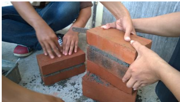
Gambar 49. Penyusunan bata merah
