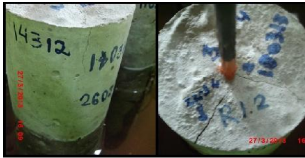
Gambar 65. Pola retak beton dengan agregat kasar recycle 1 .
