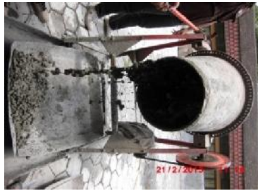
Gambar 37. Penuangan adukan beton.
