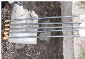
Gambar 45. Pengecatan baja tulangan.
