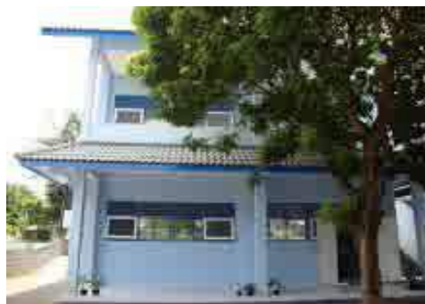
Gambar. 1. Gedung Sekolah SMK PI AMBARRUKMO 1 SLEMAN
