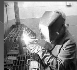
Gambar Pekerja las menggunakan las busur nyala listrik
