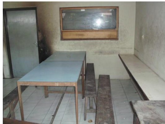
Gambar19. Kantin SMKN 2 Klaten
