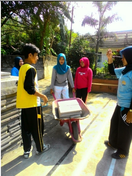
Memindahkan batako untuk pembangunan gedung baru oleh siswa dan mahasiswa PPL
