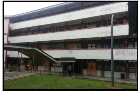
Bangunan Ruang Kelas Teori
