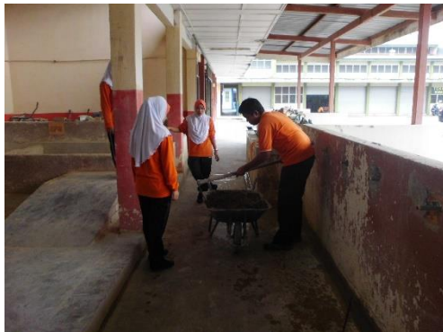
Kegiatan pembuatan mortar adukan
