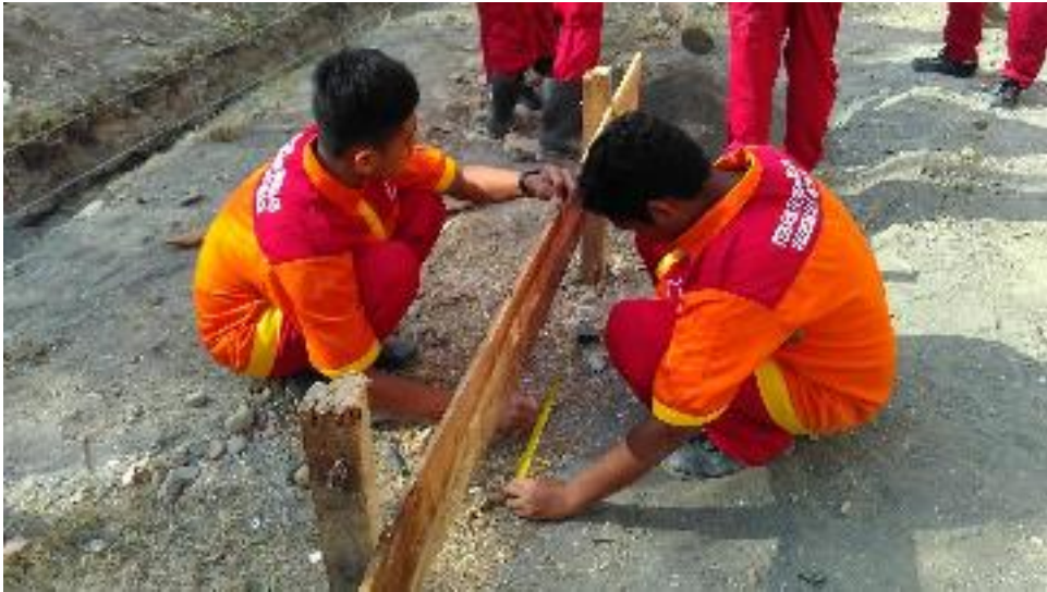
7. Mengajar pasang bouwplank
