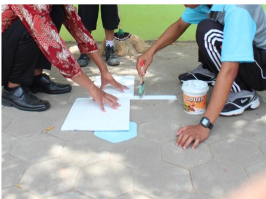
Pengecatan Lapangan Bulutangkis
