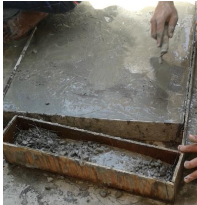
Gambar 55. Penuangan Adukan Kedalam Bekisting
