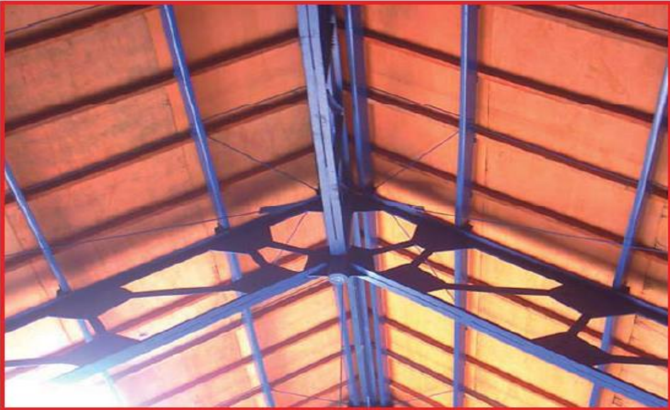
Gambar XI-42, Rangka Atap Baja
