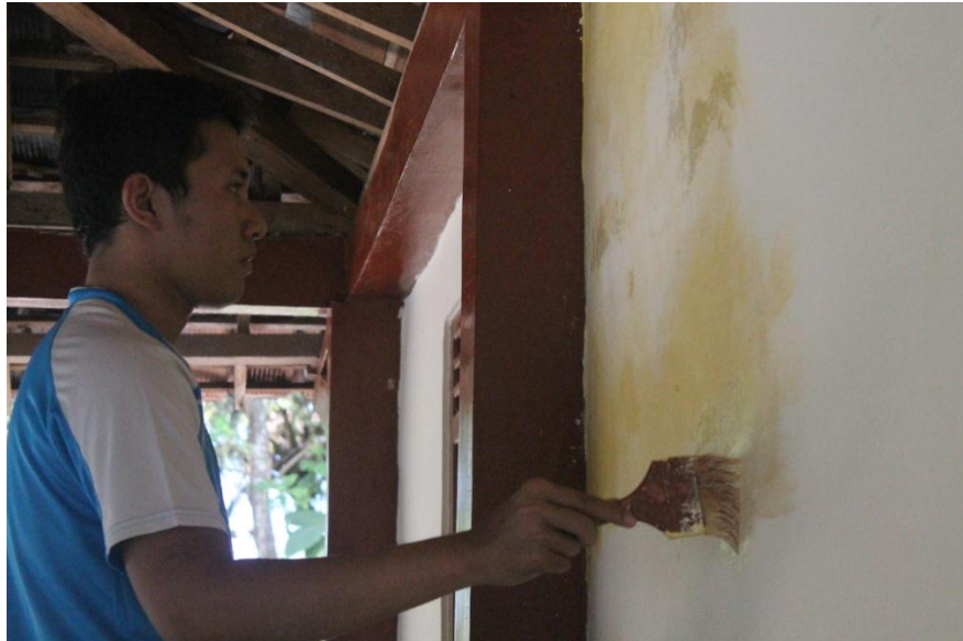
Pengecatan dan Penulisan Balai Dusun Silingi
