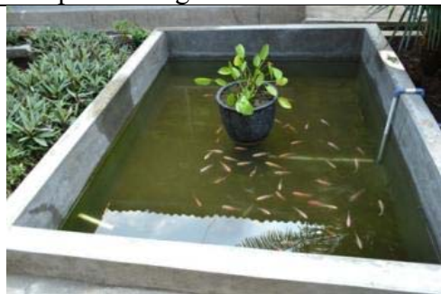
Sistem drainase untuk kolam ikan dari pembuangan air wudhu
