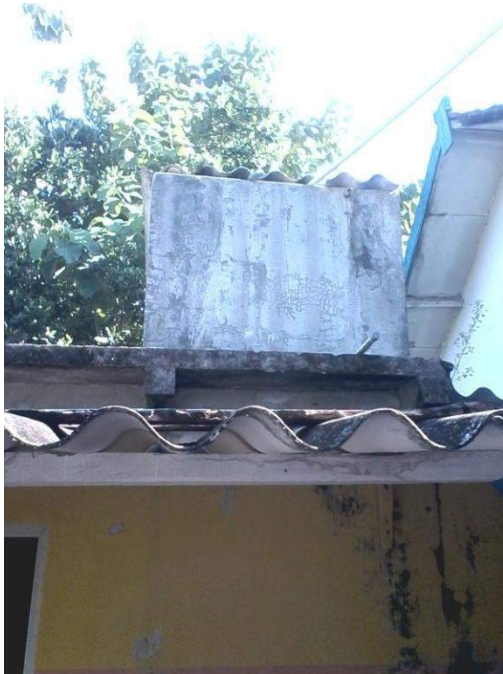
Gambar 2. Tandon Air yang Tidak Tertutup Rapat
