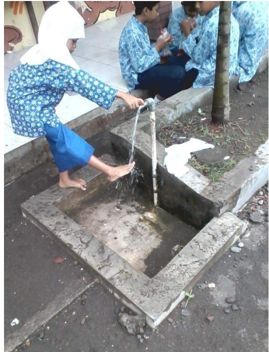
Gambar 6. Saluran Pembuangan Air Limbah yang Terbuka
