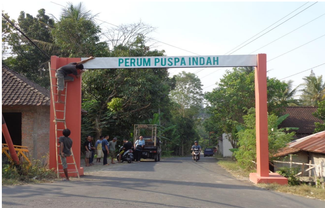
Gambar 14. Pemasangan kembali papan nama gapura Perum Puspa Indah
