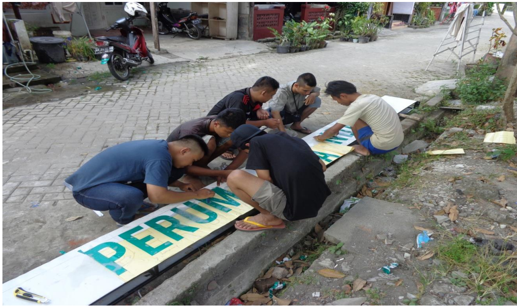
Gambar 13. Pemasangan tulisan Perum Puspa Indah
