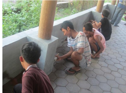
Mengecat balai nyadran
