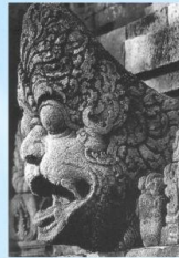
Gambar 1. Dwarapala Talang air pada candi Borobudur sebagai ornamen konstruksi
