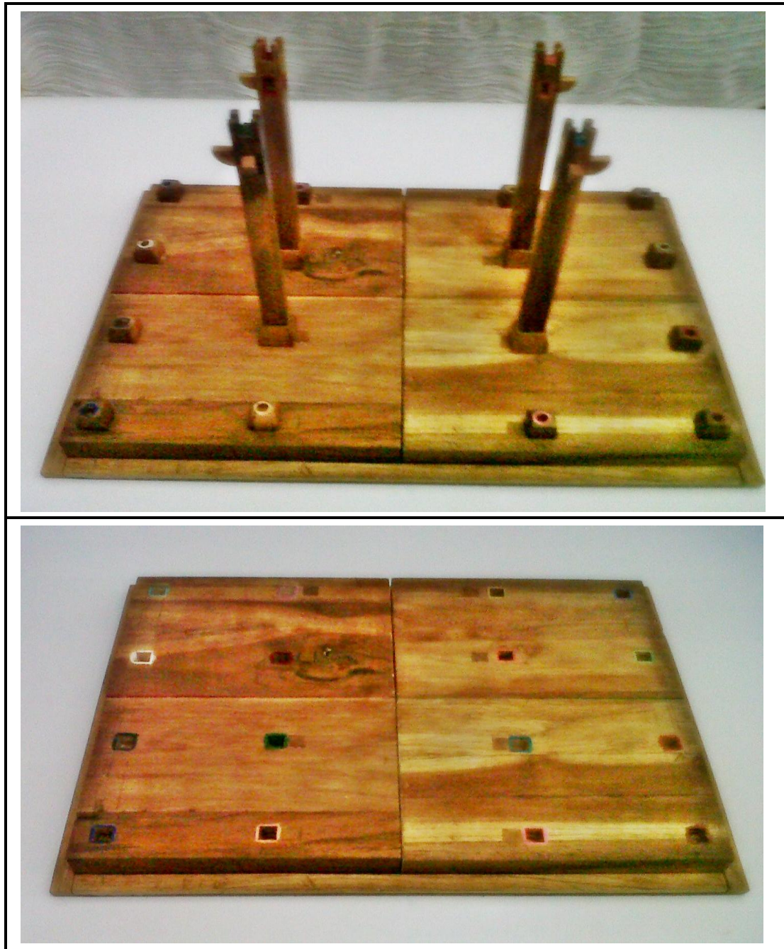
Gambar XXXVI: Kerangka saka guru, umpak, dan lantai (Sumber: Dokumentasi Wulandari Puspo Asih)
