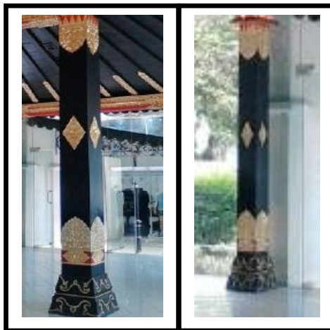
Gambar XXI: Tiang/Soko (Sumber: Dokumentasi Wulandari Puspo Asih)
