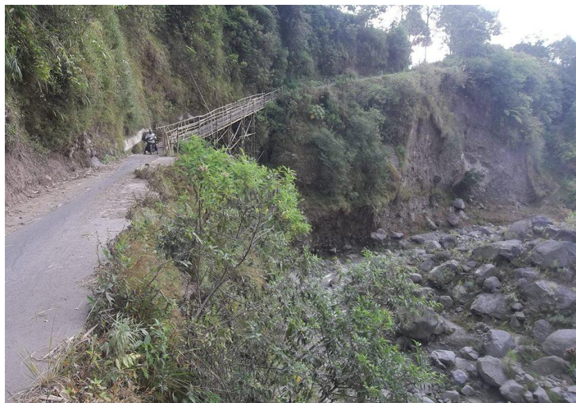
Gambar 9. Kerusakan jalur transportasi antar desa pada sempadan Sungai Pabelan akibat aliran lahar (Data lapangan, 2014)
