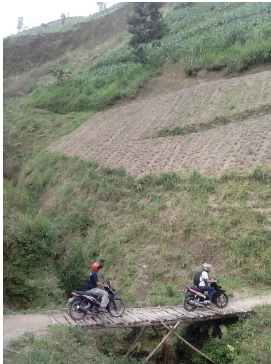
Gambar 10. Bekas longsor pada daerah dengan kemiringan lereng terjal pada lereng Gunungapi Merbabu. Mahkota longsor masih dapat dikenali dengan jelas (Data lapangan 2014)
