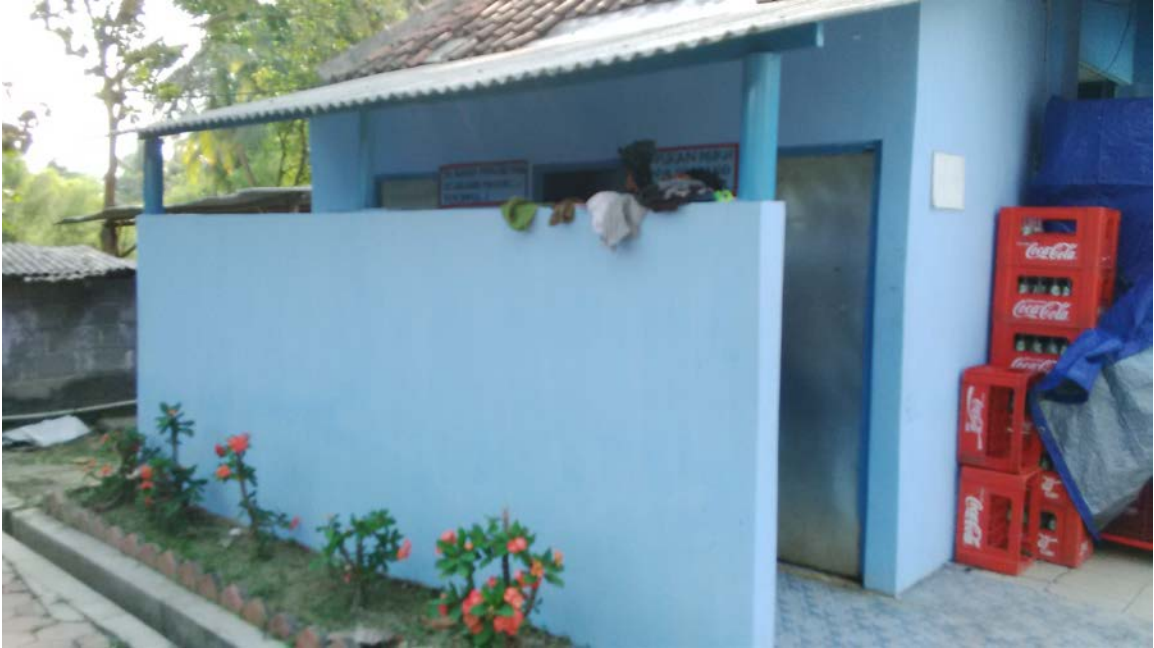
Ruang bilas dan ruang ganti
