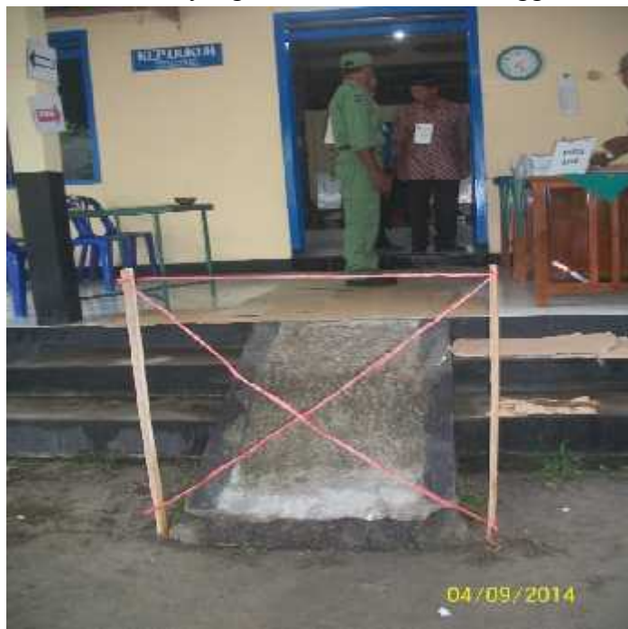
Gambar 4. TPS yang tidak aksesibel bagi penyandang disabilitas daksa.
