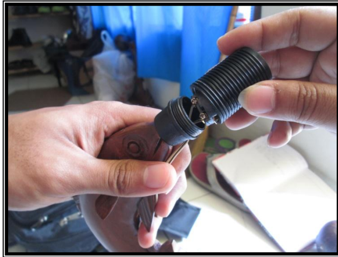
Gambar 54 : Proses pemasangan fitting lampu
