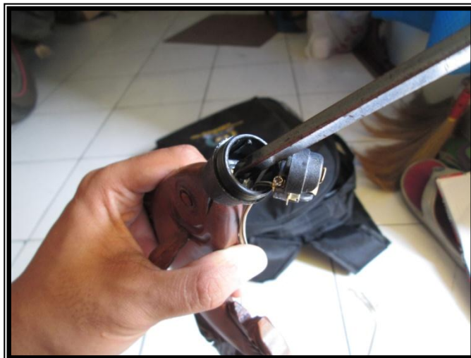
Gambar 53 : Proses pemasangan fitting lampu (Sumber: dokumentasi penulis )
