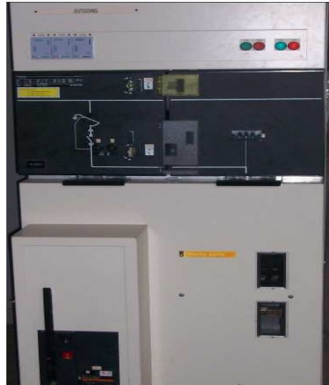
Gambar 1. Kubikel Tegangan Menengah
